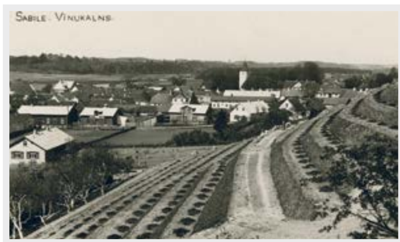
118. attēls. Skats uz Sabiles Vīnkalnu, 20. gs. 30. gadi (attēls no LNDB kolekcijas “Zudusī Latvija”, oriģināls LNB krājumā)
